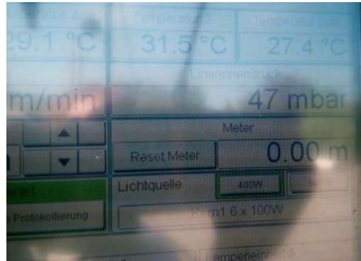
Con solo 47 mbar se alcanza la presión de instalación, véase la imagen de la izquierda
